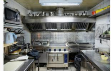
厨房機器の入替
